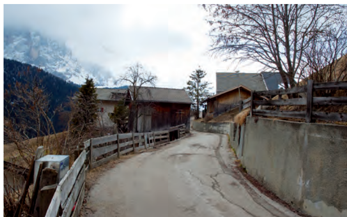
È stato approvato il progetto esecutivo per la costruzione del tratto di strada comunale "Ploc-Janmëine" in località "Daunëi"
